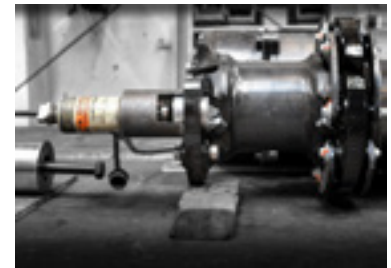
Sostituzione dei cuscinetti sferici
